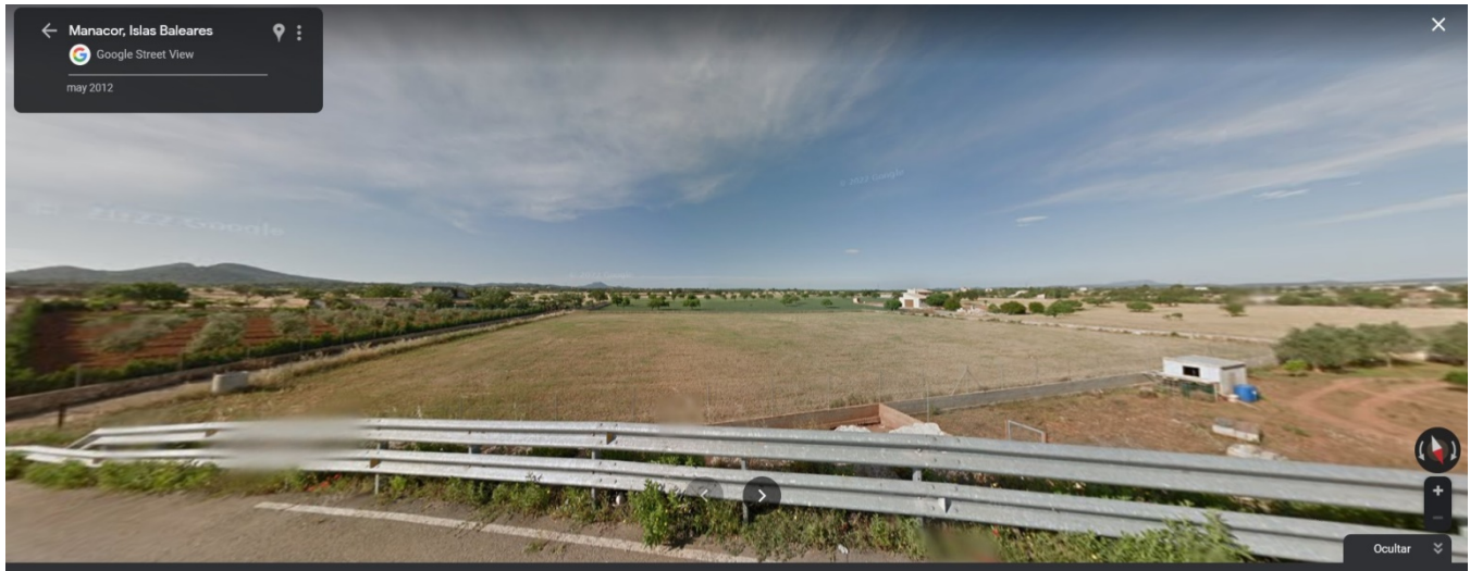
Carretera Ma-15 (via de servei), Direcció SO.
