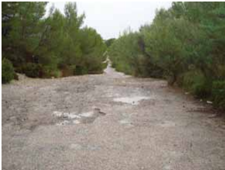
Baixada a cala Estreta, on es restringirà l'accés amb vehicles.
